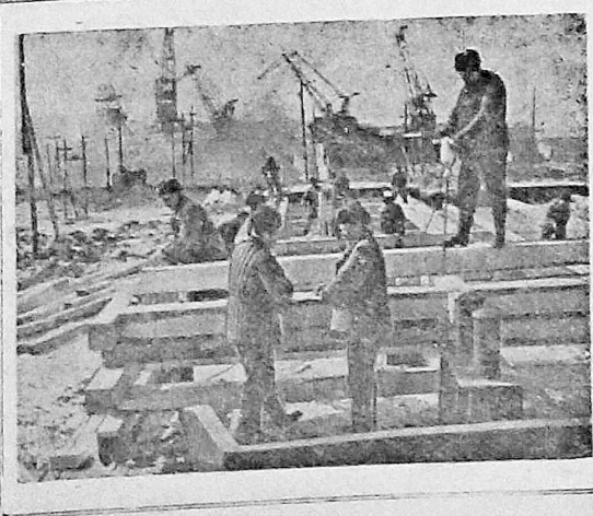
Иркутская область. На строительстве первой на Ангаре Иркутской гидроэлектростанции развернуется социалистическое соревнование в честь 1 Мая. Коллектив управления плотин и каналов готовится к перекрытию русла Ангары, которое намечено в мае текущего года. Сейчас бригада плотников А. Чернуха заканчивает работы по надстройке барж, предназначенных для сооружения наплавного моста. На снимке: бригада за надстройкой барж. На переднем плане — мастер И. Каранкевич и бригадир А. Чернух (справа). (Фотохроника ТАСС).
